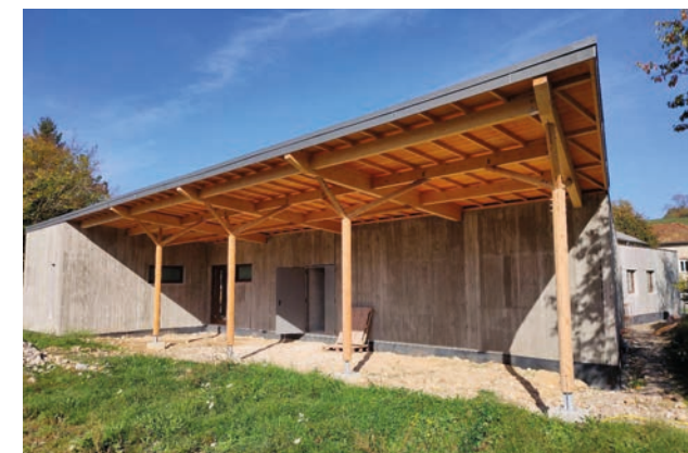
Le préau avec couverture en zinc
