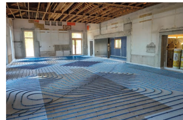
Pose du plancher chauffant
