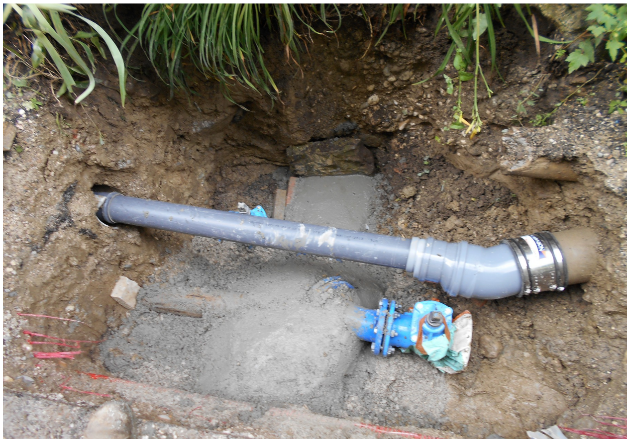
réparation d'un réseau d'assainissement
