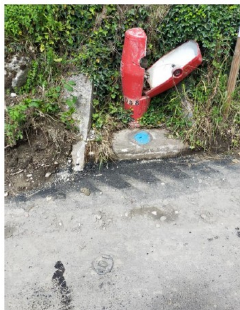
Le même poteau incendie après travaux (remplacement de la conduite, remblaiement et réalisation du tapis d'enrobé)
