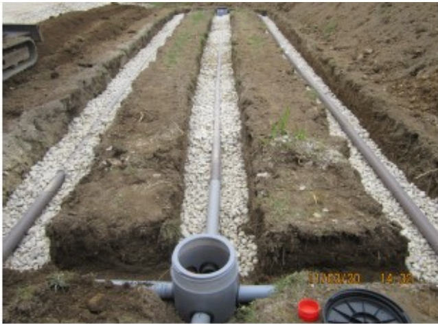
Réalisation de tranchées d'épandage
