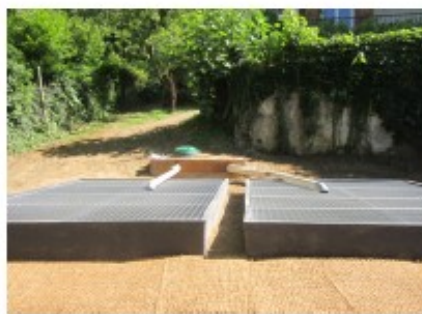
Réalisation d'une filière phytoépuratrice : Filtres plantés de roseaux (filière disposant d'un agrément ministériel)
