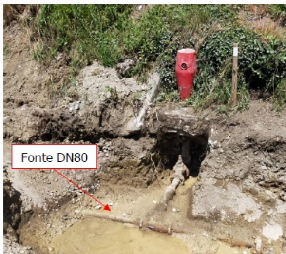
Poteau incendie existant branché sur l'ancienne conduite en Fonte grise qui a été remplacée
