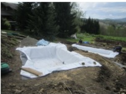
Réalisation d'une filière phytoépuratrice : Filtres plantés de roseaux (filière disposant d'un agrément ministériel)
