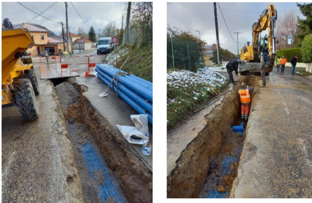
Tranchée et pose du réseau d'eau potable
