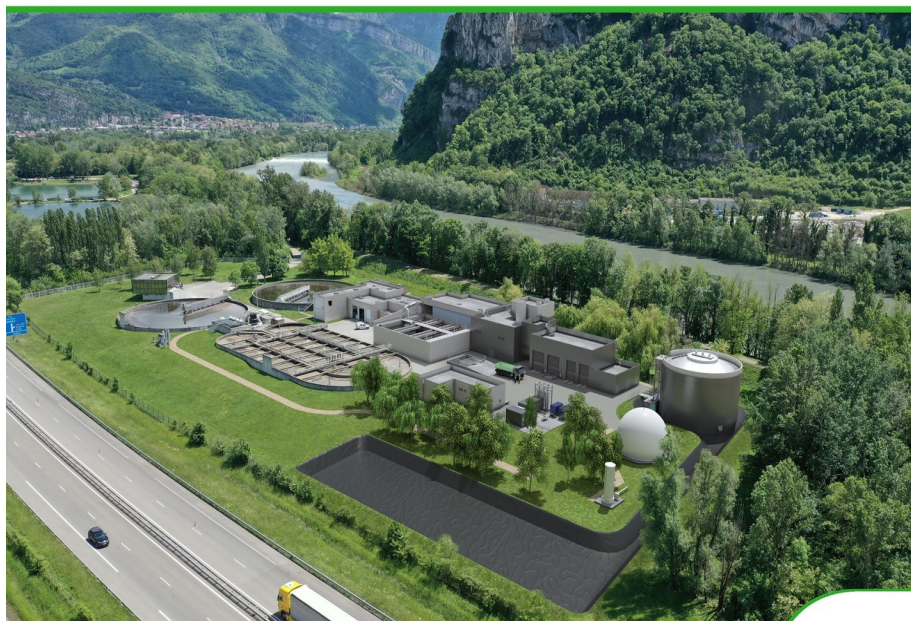
Vue aérienne - Nord-Ouest
