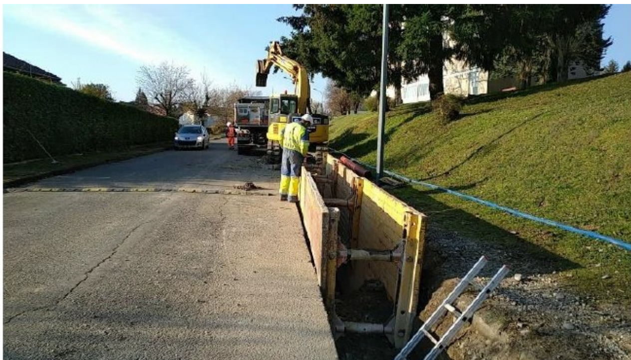
Tranchée ouverte avec protection par des blindages – rue René Payot
