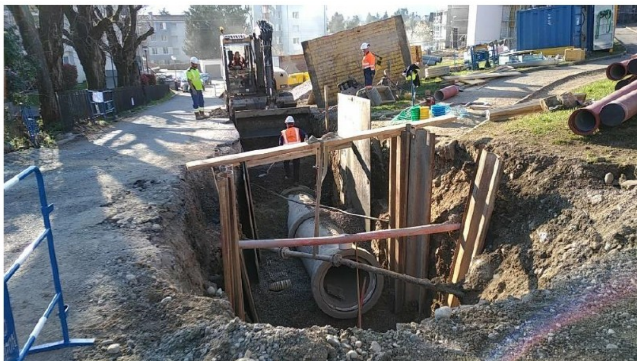
Pose de conduites – rue des Hortensias
