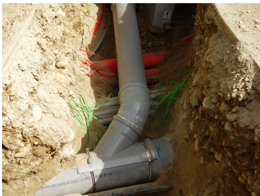
réparation d'un réseau d'assainissement
