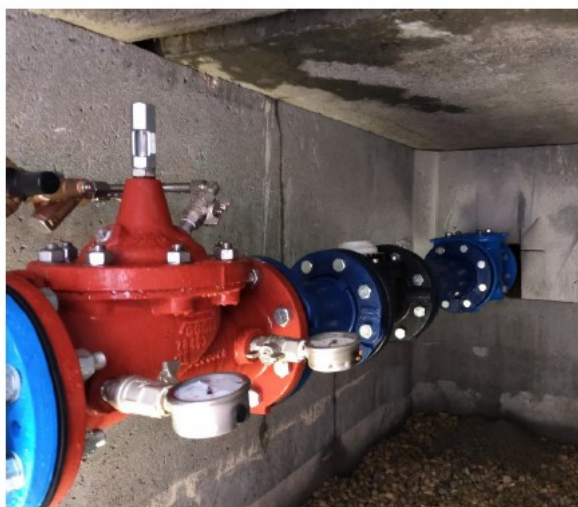
Intérieur d'un nouveau regard comprenant un stabilisateur de pression
