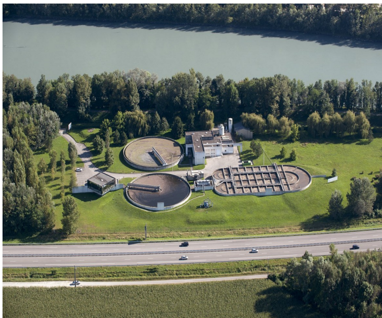
Vue sur la station existante
