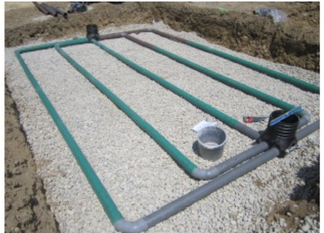
Réalisation d'un filtre à sable non drainé
