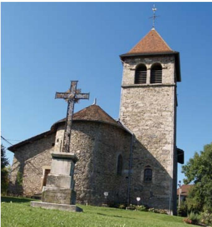
Ce diagnostic précise, photos à l'appui, **le très mauvais état général de la toiture** et la nécessité de réaliser des travaux de couverture au plus vite. L'ensemble des couvertures en tuiles de terre cuite est détérioré. De nombreuses tuiles sont gelées ou cassées ce qui entraîne des infiltrations et des putréfactions en sous-face.
